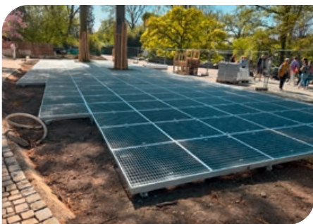
Vorplatz Villa Bodinus, Köln – Einbau
