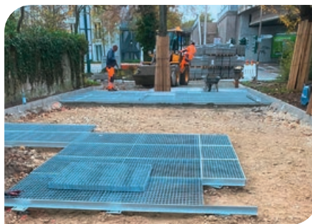
Radweg am Zentralfriedhof, Erlangen – Einbau
