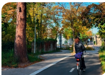
Radweg – überbaut mit Pflaster und Asphalt
