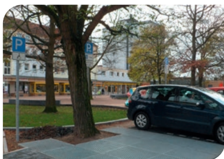
Offene Wurzelbrücke auf Parkplatz
