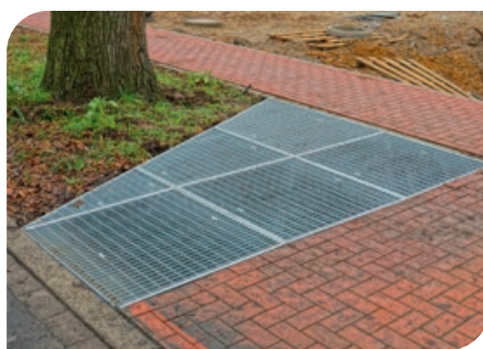
Offene Wurzelbrücke mit Sondergittern als Gehweg
